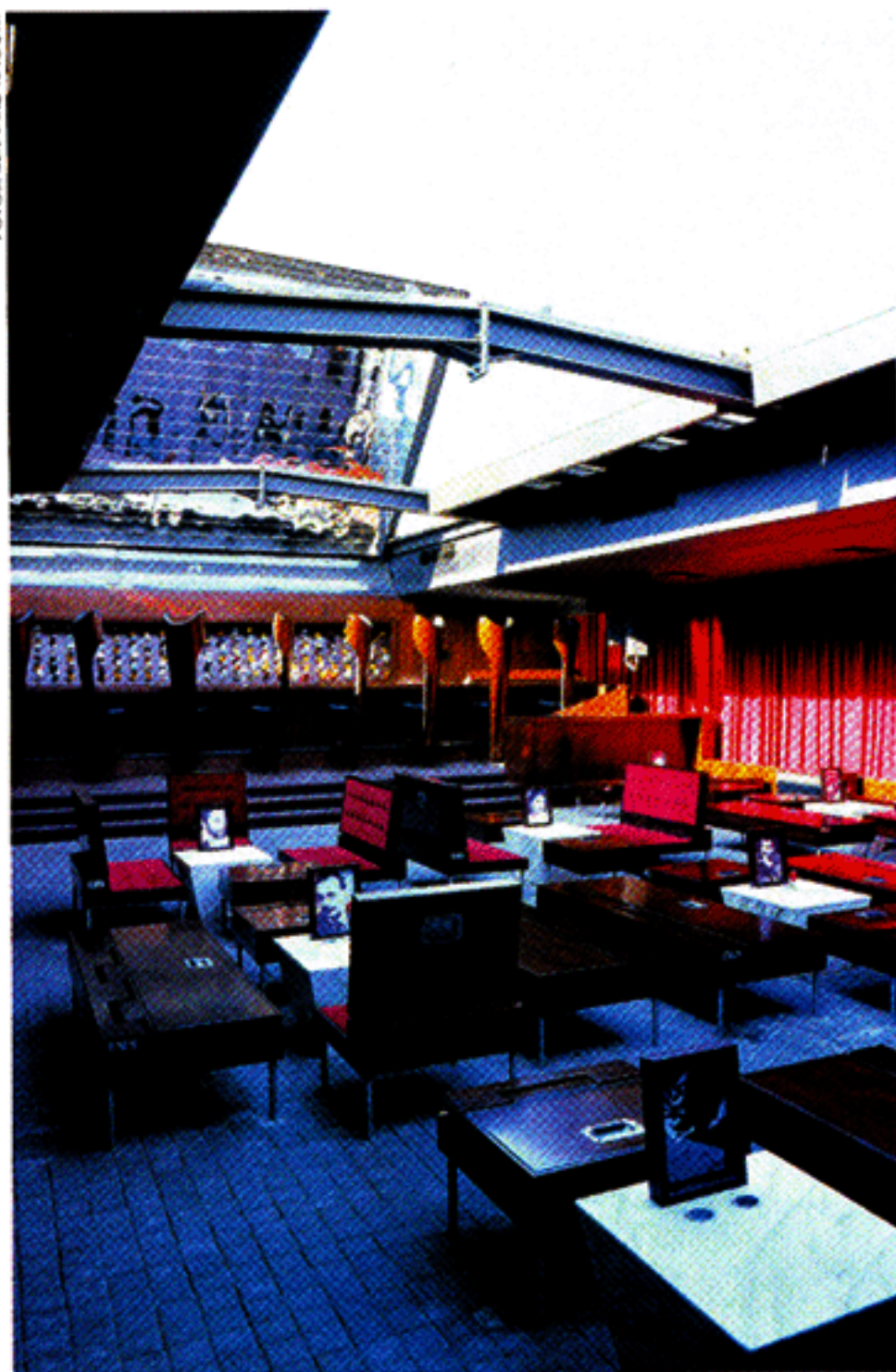
A cobertura de aço da B0 18 contém a porta de entrada que se abre graças a cinco placas movidas por pistão hidráulico. Assim, durante o dia, a luz natural invade os ambientes do “submarino”
